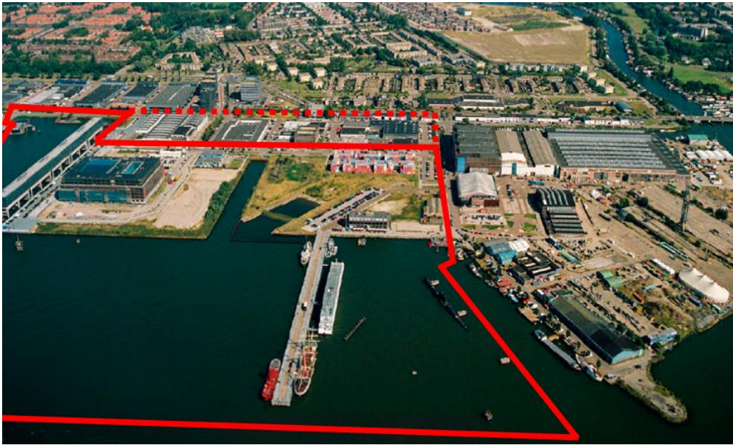
Figuur 12.1 – NDSM-werf West gezien vanuit het zuiden, september 2009 LIX
